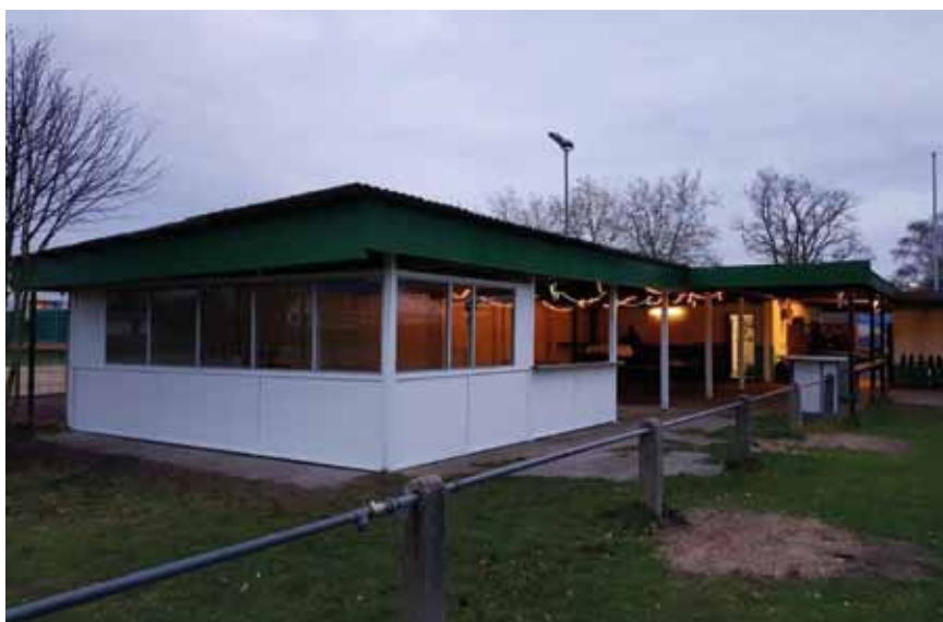
... neu mit wesentlicher Unterstützung durch Location-Design
