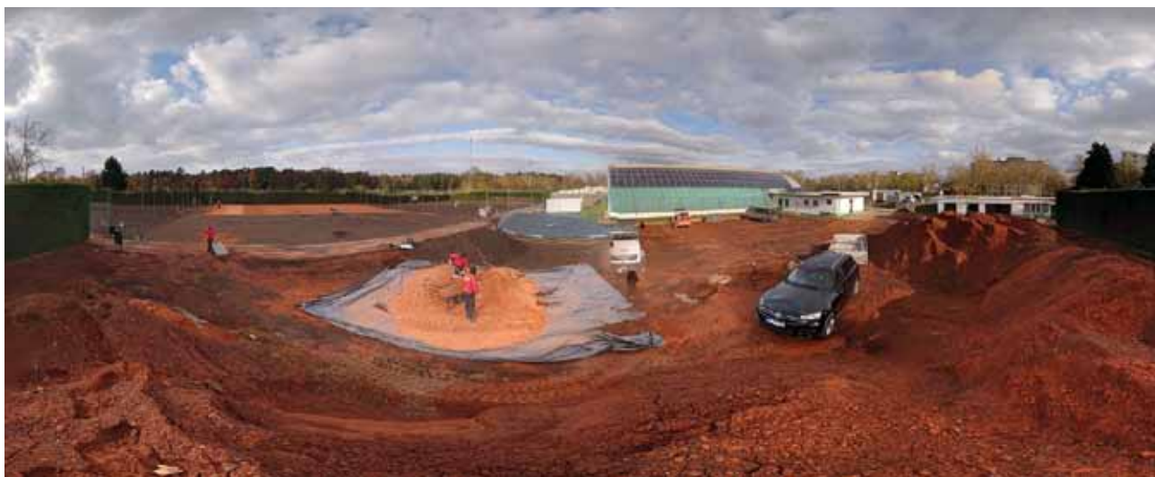
Während Berge alten Ziegelmehls auf ihren abtransport warten, ist neues auf Platz sieben schon verlegt
