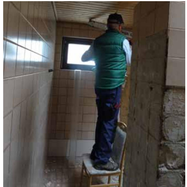
Decken, Lampen, Fliesen ... alles muss raus
